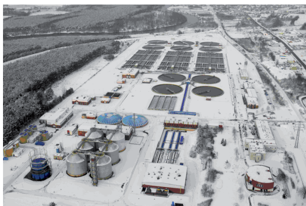
Centralna Oczyszczalnia Ścieków w Koziegłowach położona jest na prawym brzegu rzeki Warty, na terenie gminy Czerwonak.
