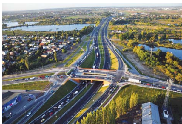
Przebudowana do rangi drogi ekspresowej ulica Głogowska.
