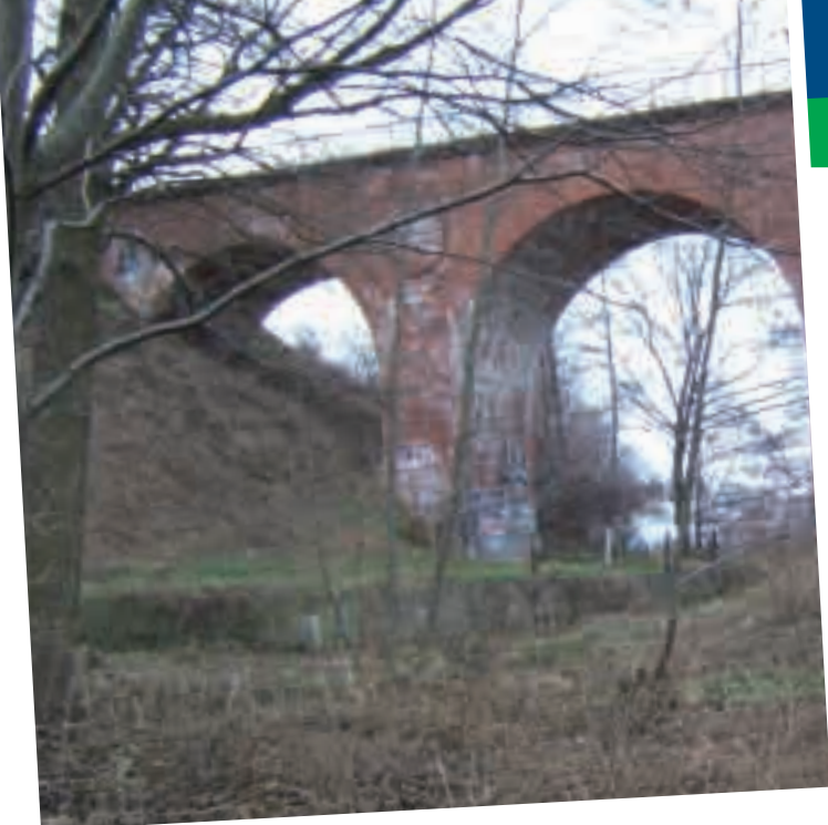
Widok ogólny mostu w km 107,596 nad rzeką Wirenką
